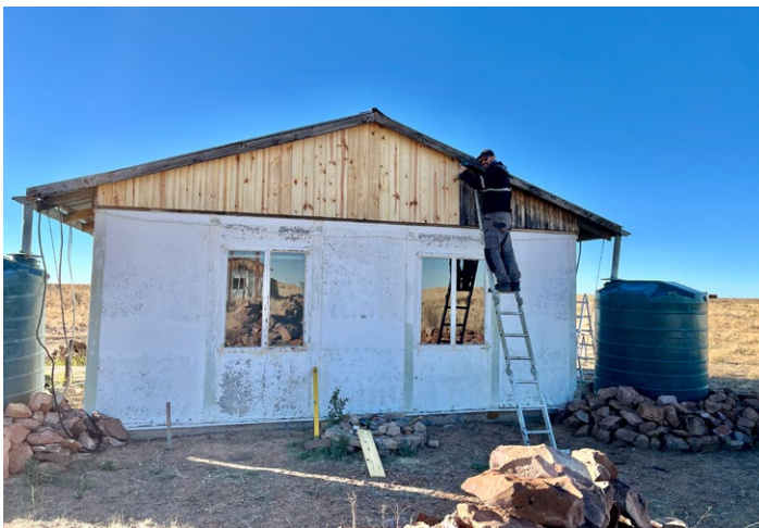
Abb. 3: Alex montiert die neuen Giebelbretter an Haus 1
