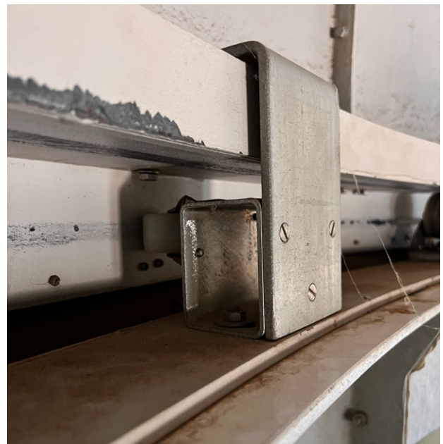
Abb. 3: Rollenführung der Kuppel
